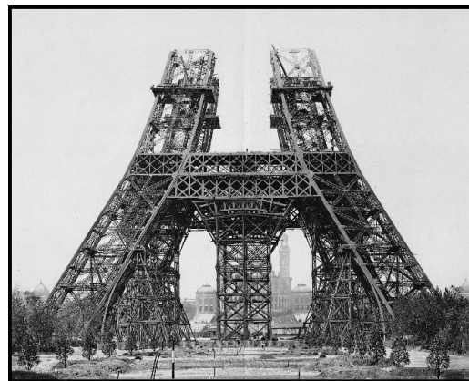
La tour en cours de travaux
